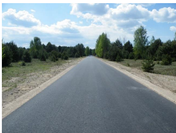
Przebudowa ulicy Cichej w miejscowości Sitne
